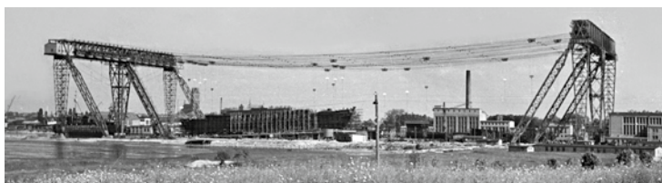
Werft mit Kabelkrananlage, 1958
