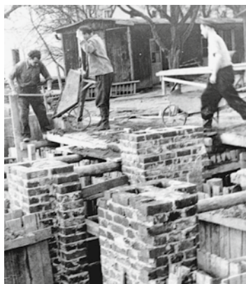
Die späteren Mieter der 26 neuen Wohnungen in Wismar-Süd mussten in der Freizeit selbst Hand anlegen.
